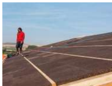
Isolation de toiture
