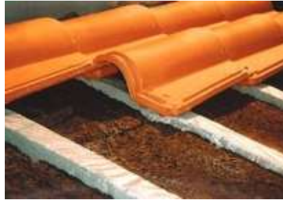
Isolation des combles
