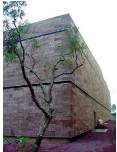
Pavillon du Portugal (Arch. Siza Vieira & Souto Moura)
