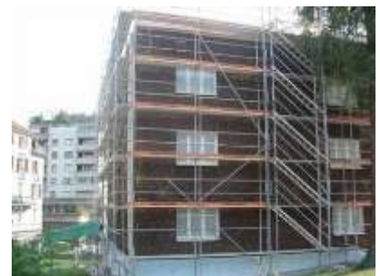
Isolation de murs extérieurs
