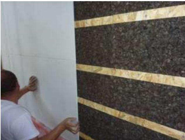
Lambourdé + plaque de plâtre Gyptec
