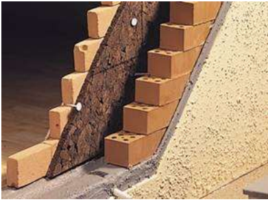
Isolation des cavités
